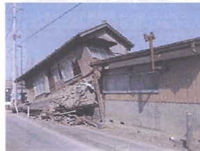
倒壊した木造建物
