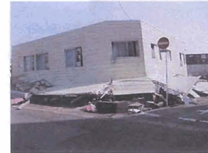
木造2階建て店舗の倒壊
