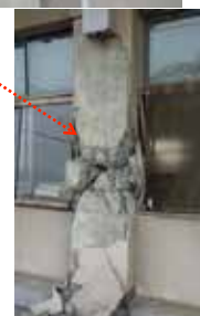
Falla de cortante por efectos de columna corta
