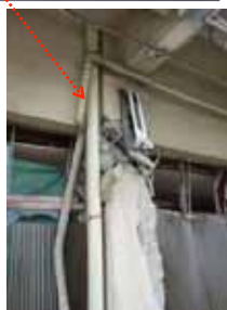
Falla de cortante por efectos de columna corta
