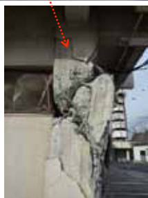
Falla de cortante por efectos de columna corta
