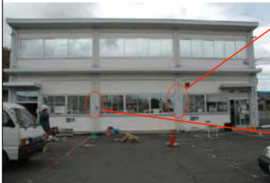
Falla de cortante por efectos de columna corta
