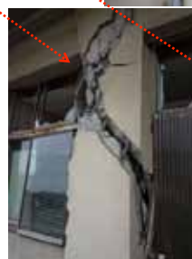
Falla de cortante por efectos de columna corta
