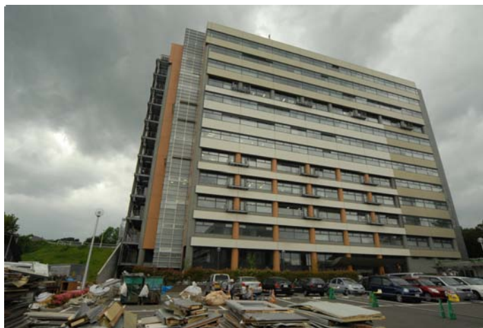
Edificio sobre pilotes de acero de 25 m
